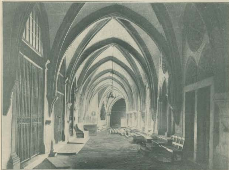
AS OBRAS DA SÉ DE LISBOA — OS CLAUSTROS
