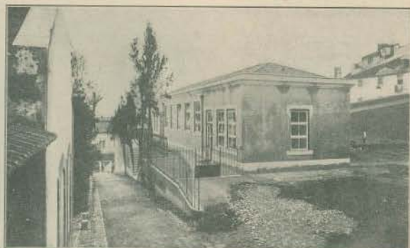
A FACHADA DA INSTALACÃO
