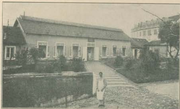
PAVILHÃO DO LABORATORIO
