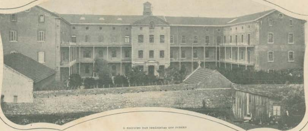
O EDIFICIO DAS IRMÃS DAS POBRES
