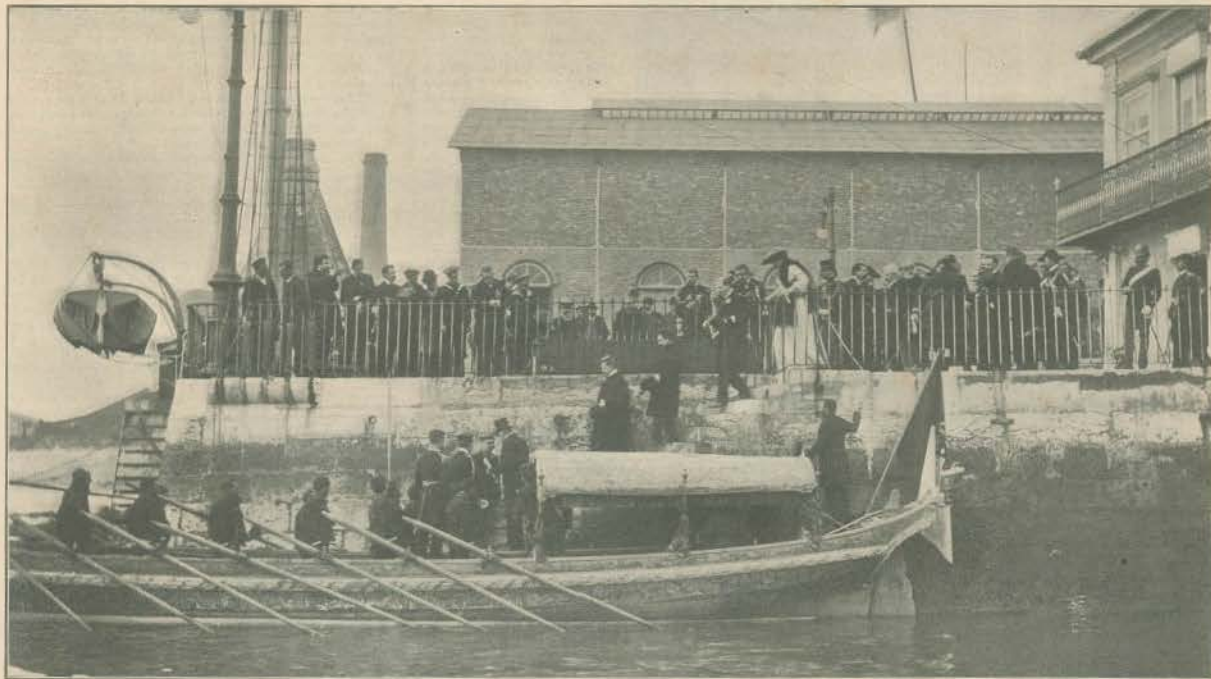
NO CAES DA INSPECÇÃO DO ARSENAL
