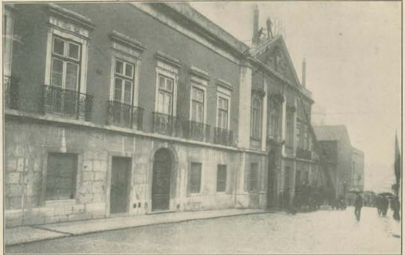
A EMBAIXADA DE FRANÇA EM LISBOA—A fachada
