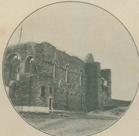
A NOVA EGREJA EM CONSTRUÇÃO
