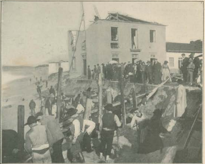
A DEMOLIÇÃO D'UMA CASA
