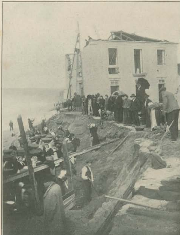
TRABALHOS DE ATERRAMENTO
