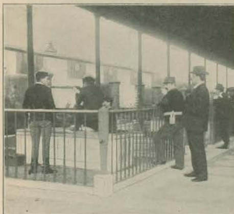
UM ASPECTO DA CARREIRA
