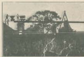
O TABOLEIRO ASSENTE NO SEGUNDO PILAR
