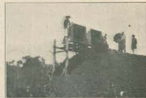
A CONSTRUÇÃO DO ATERRO
