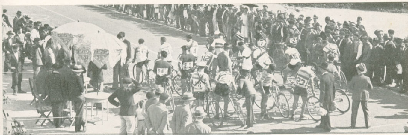
Num percurso de 118 quilómetros, em 5 voltas a um circuito, compreendido entre Estoril, Carcavelos, S. Domingos de Rana, Alcábaldeche e Estoril, disputou-se, a prova ciclista do «Grande Prémio do Estoril», organizada pelo Sporting Club do Estoril, com a colaboração da Sociedade Propaganda da Costa do Sol. Cesar Luitz venceu a corrida com o tempo de 4 h. e 45. seguido de João Gomes, com 4 h. e 9 s.; de José Marques, com 4 h. e 18 s.; de Gil Moreira, com 4 h., 2 m. e 2 s., e de João Francisco, com 4 h. e 4 m.
