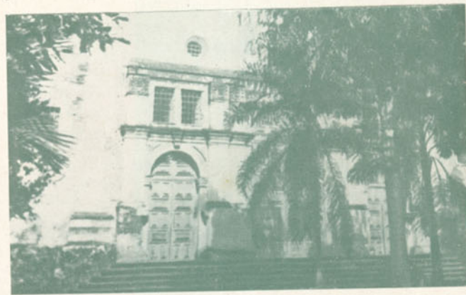
IGREJA SACRIFICADA AO PROGRESSO — Na cidade da B. ta a prefeitura teve de sacrificar a velha Igreja da Sé para abrir uma larga avenida. Era uma reliquia do velho Brasil. A sua construção data de alguns séculos. Era das mais antigas do Brasil
