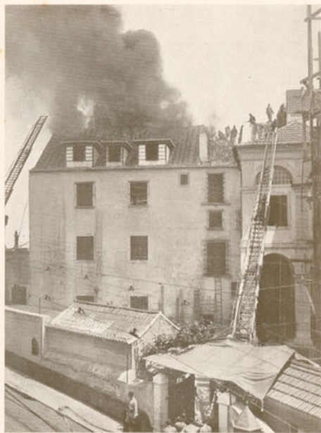
No grupo II, da cadeia do Limoeiro, manifestou-se um incêndio, provocado pela explosão dum maçarico. O fogo, que foi prontamente atacado, não se pelos bombeiros, como pelos presos, devorou uma parte do telhado da ala velha do edifício.
