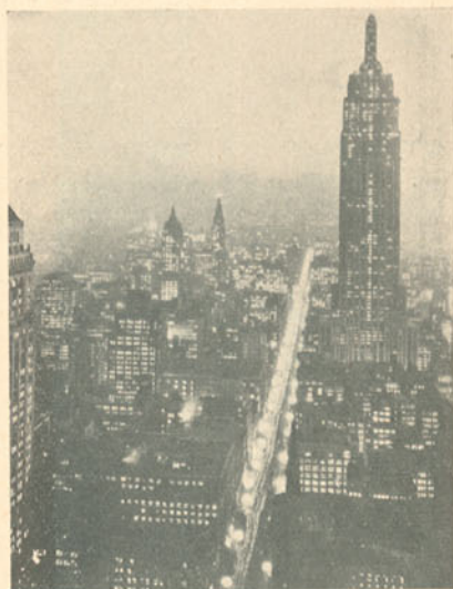
O Empire State Building, o mais alto edifício do mundo, mede 375 metros de altura e está construído em Nova York. A sua construção representa um record , pois calculado que levaria 2 a 3 anos, foi completada em 19 meses. Todas as máquinas empregadas nesta grande obra, desde as escavadoras a vapor, até às gigantescas gruas; desde as brocas de furação de rocha, até às cravadeiras de rebites; desde as dezenas de camions aos transportadores aéreos, foram lubrificadas com óleos «Cargoyles» da Vacuum Oil Company.
