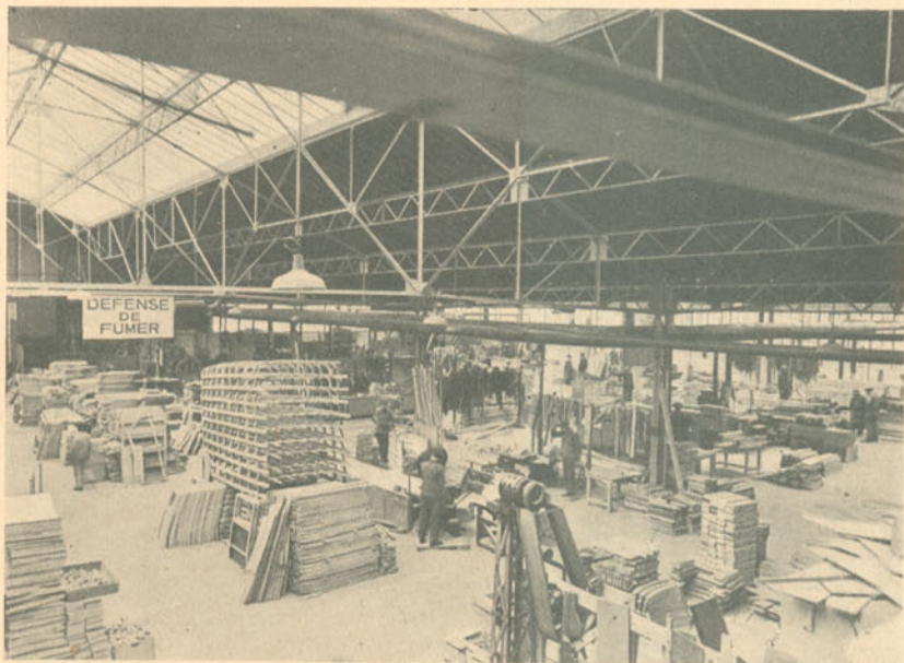
A enorme superfície deste armazém dá uma ideia da quantidade de materiais a empregar numa fábrica de automóveis moderna
