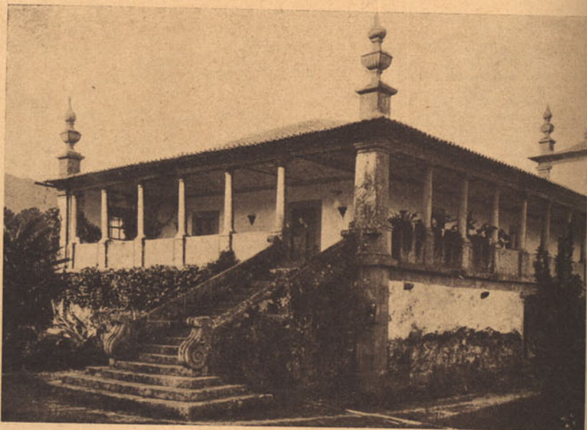
Casa de Pomarchão — Escadaria e varanda claustrada
