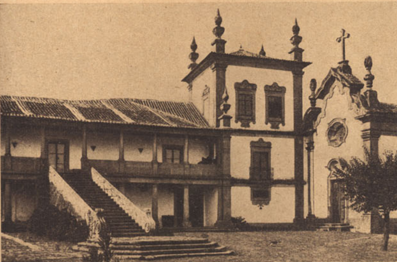
Casa do Pomarchão — Fachada principal, torre e capela
