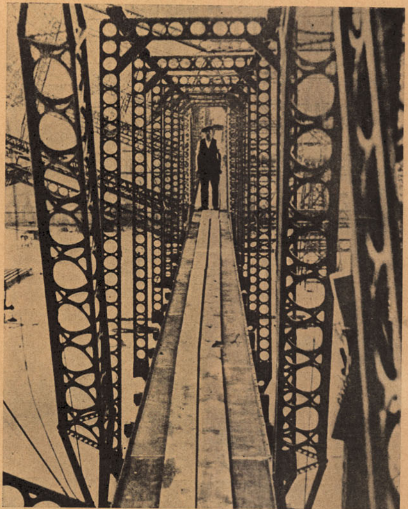
O grande passadiço dos dirigíveis que virá a servir de passeio dos passageiros e comunicação entre as várias dependências
