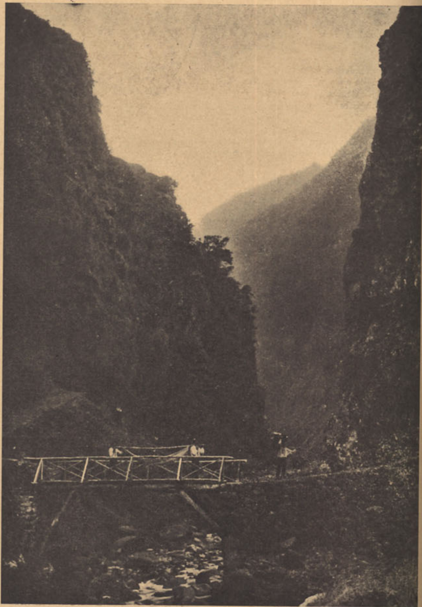
Ponte sobre uma levada em Santa Ana
