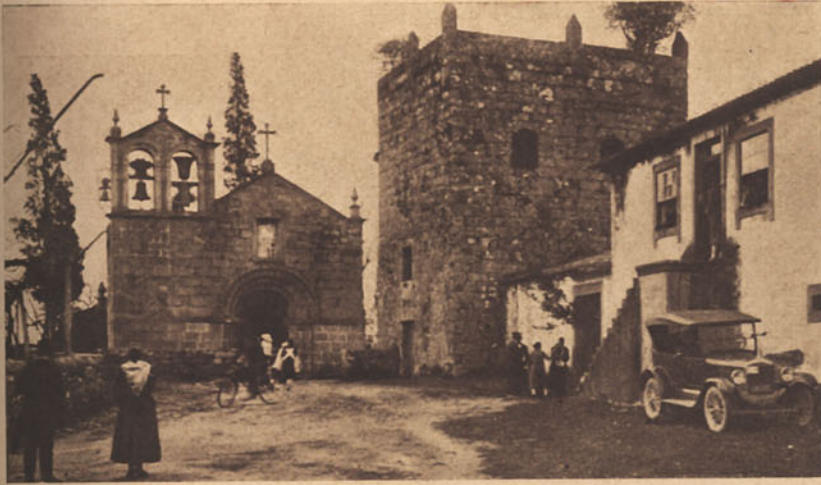
Igreja românica de Manhente, vendo-se ao lado a torre da antiga Casa do Hospital
