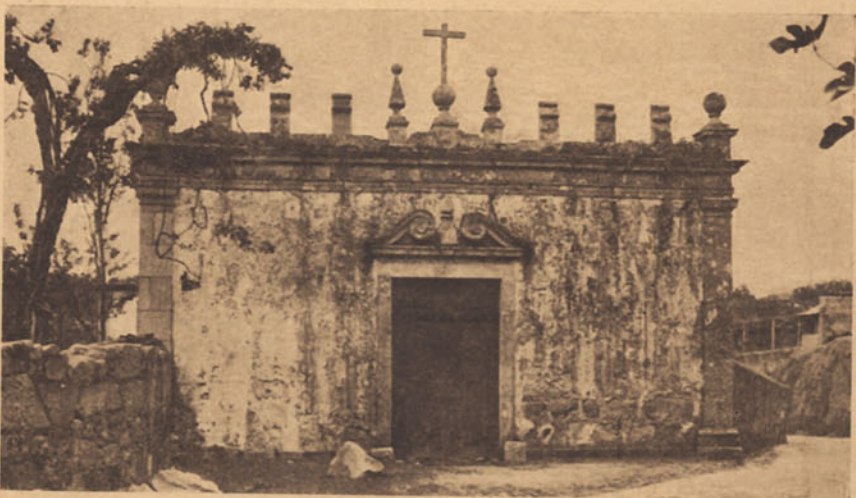
Portal da Casa dos Paços de Cima
