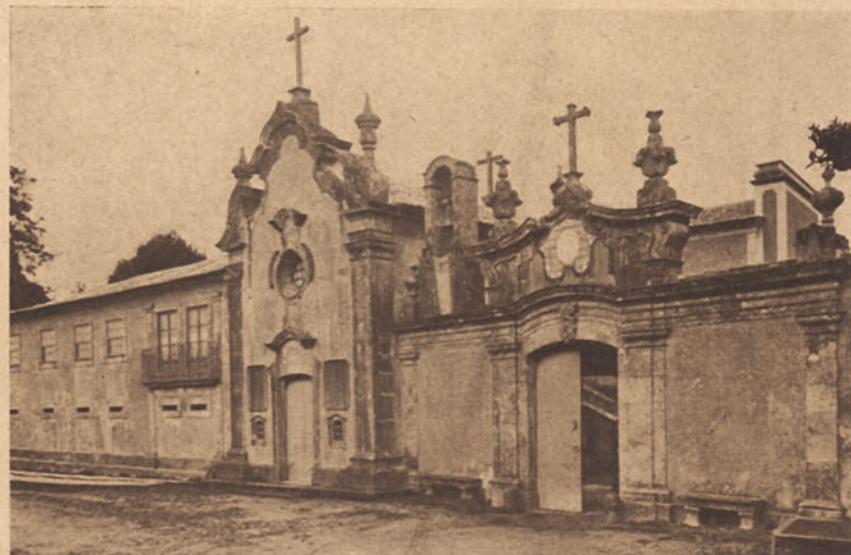
Barcelos — Solar da Espregueira (vista exterior)
