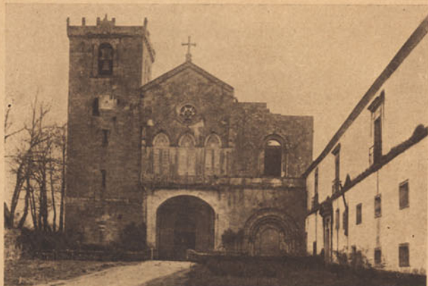
Barcelos — Fachada da igreja de Vilar de Frades
