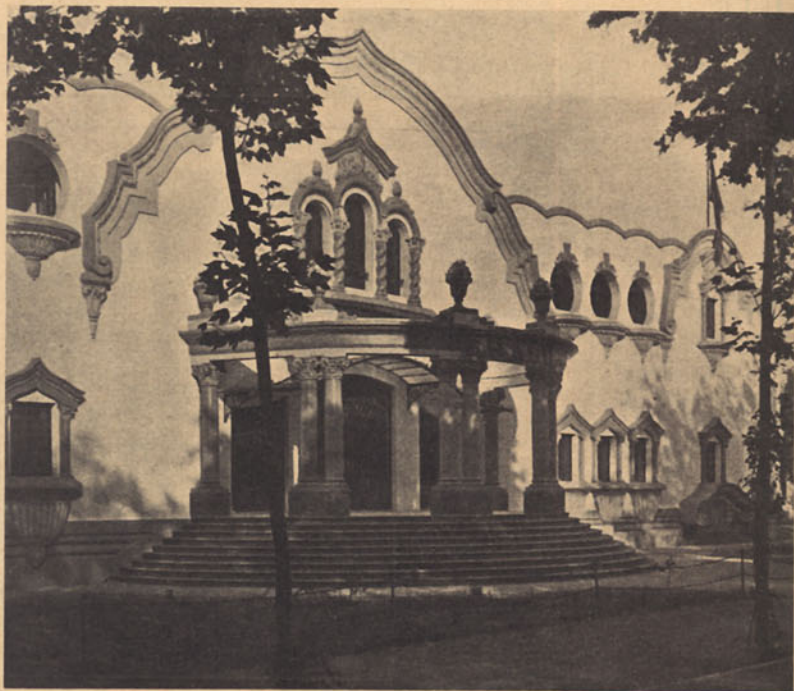
Vista exterior do Pavilhão dos Estados Unidos do Brasil
