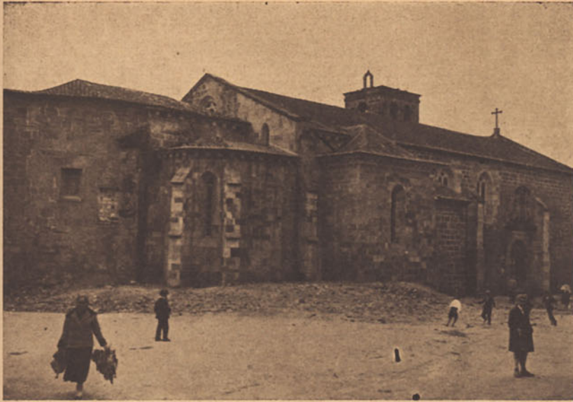
Igreja matriz, lado norte, em reconstrução
