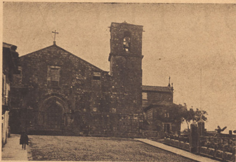
Igreja matriz, fachada e torre, vendo-se no lado direito o muro ameiado que circunda as ruínas (Monumento nacional)
