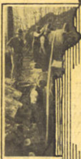
Milhares de kilometros de cabo subterraneo.
