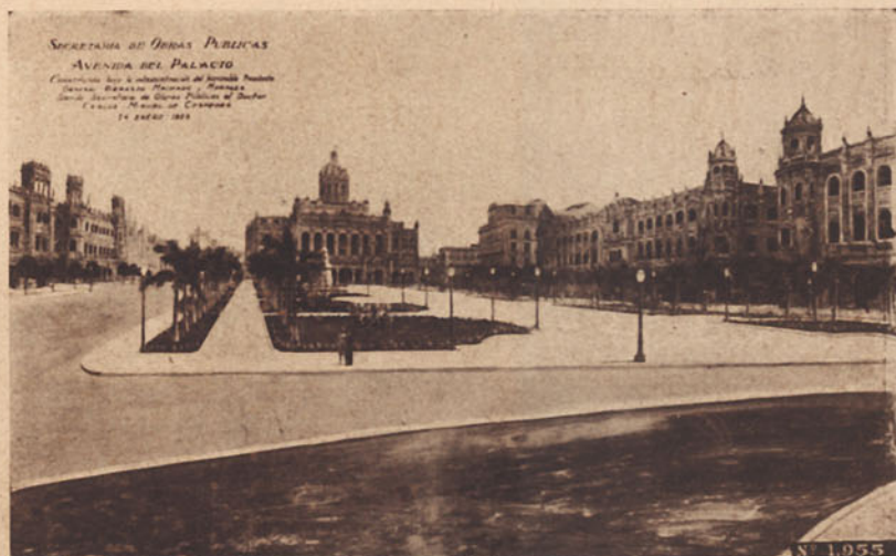
Avenida do Palácio, construída em 48 horas por 2.000 operários
