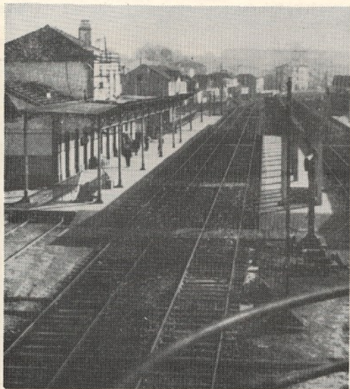
Troço da linha férrea, em Ermezinde, incluída no plano de renovação integral de via, agora aprovado pelo Governo
