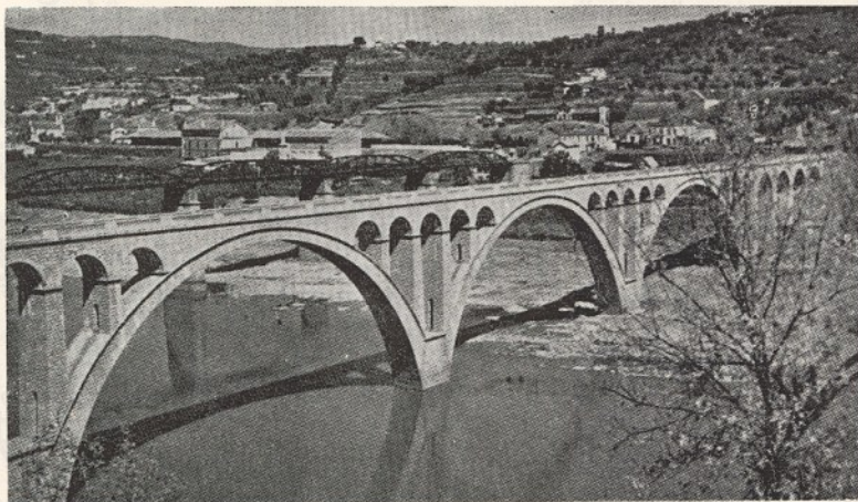
Ponte sobre o Douro na Régua
