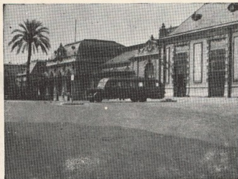
NICE — Estação de Caminho de Ferro
