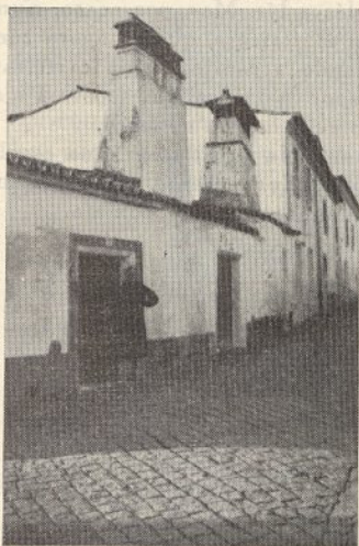
CRATO — Rua da Sobreira (séc. XVII). Dignas de reparo as altas chaminés.
