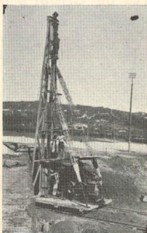
Esecução de estacas de betão armado moldadas no terreno para as fundações da Escola Comercial e Industrial de Coimbra
