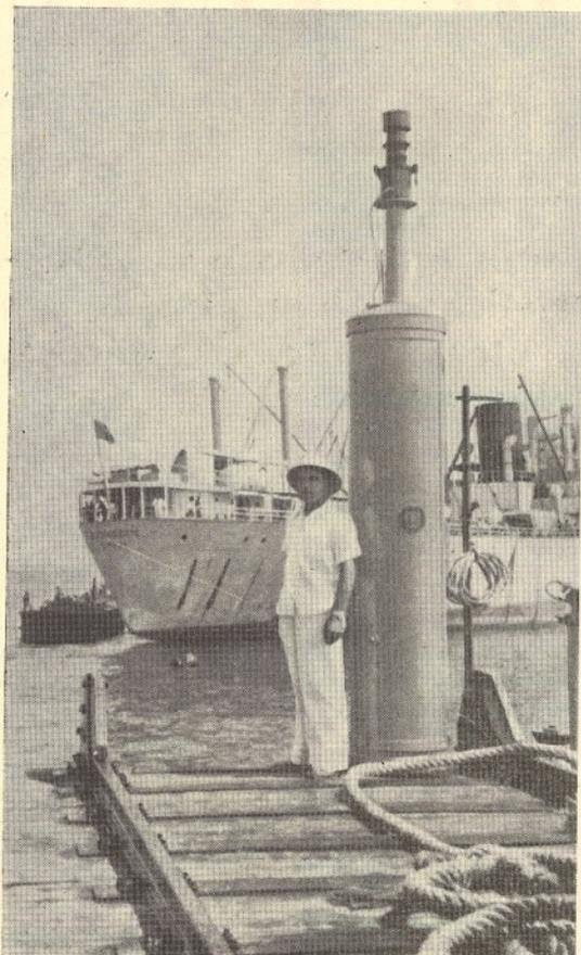
Regulador automático de profundidade de mar junto à ponte-eais
