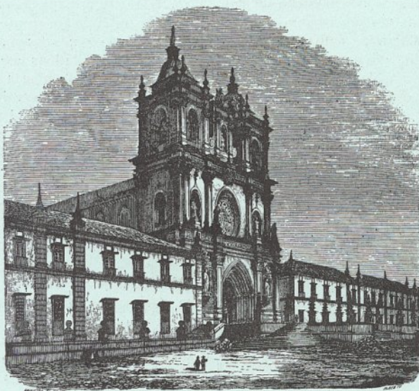
Mosteiro de Santa Maria de Alcobaça (Arquivo Pitoresco, 1869)
