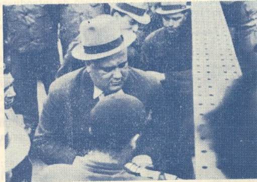
Cerimónia simbólica do assentamento da quilha do petroleiro actualmente em construção no Arsenal do Alfeite, vendo-se o administrador sr. eng. Joaquim Perestrello de Vasconcellos cravando o primeiro rebite
