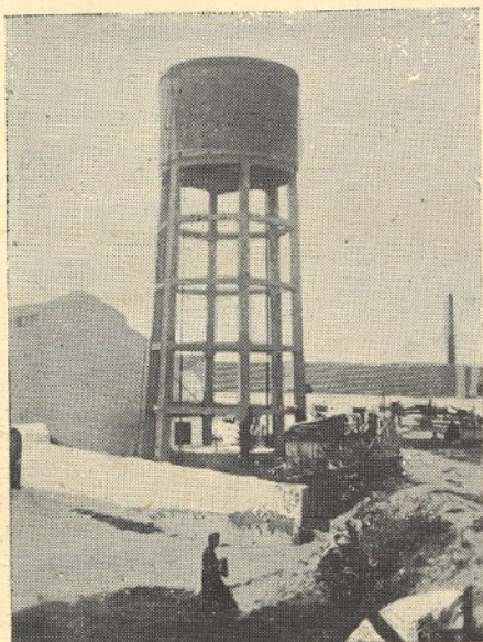
Antigo reservatório de água
