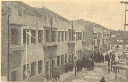
Bairro de Providência do Ferroviário Reformado
