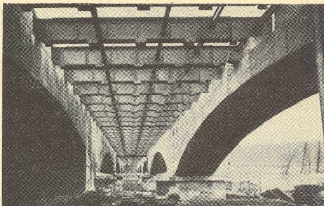
Vigamento metálico apoiado no antigo e num dos novos arcos
