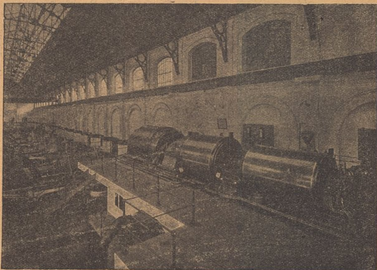
O turbo grupo a vapor de 5,000 kilowatts da Central de Massarelos da Companhia Carris de Ferro do Porto
