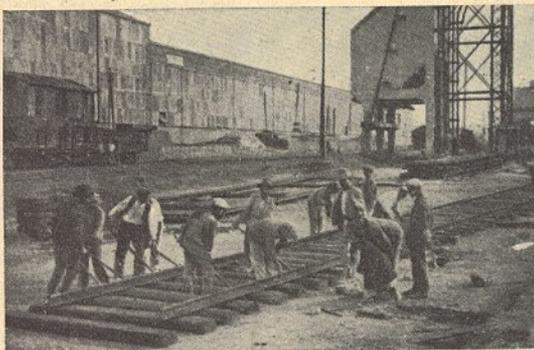
Trabalhos de construção de 2.ª via Barreiro — Lavradio. A' esquerda vê-se o exterior da nova oficina de material circulante já em laboração desde Abril de 1934. Em frente vê-se parte da carvoeira mecânica cuja estrutura metálica foi fornecida também pela casa William Beardman juntamente com as oficinas.
