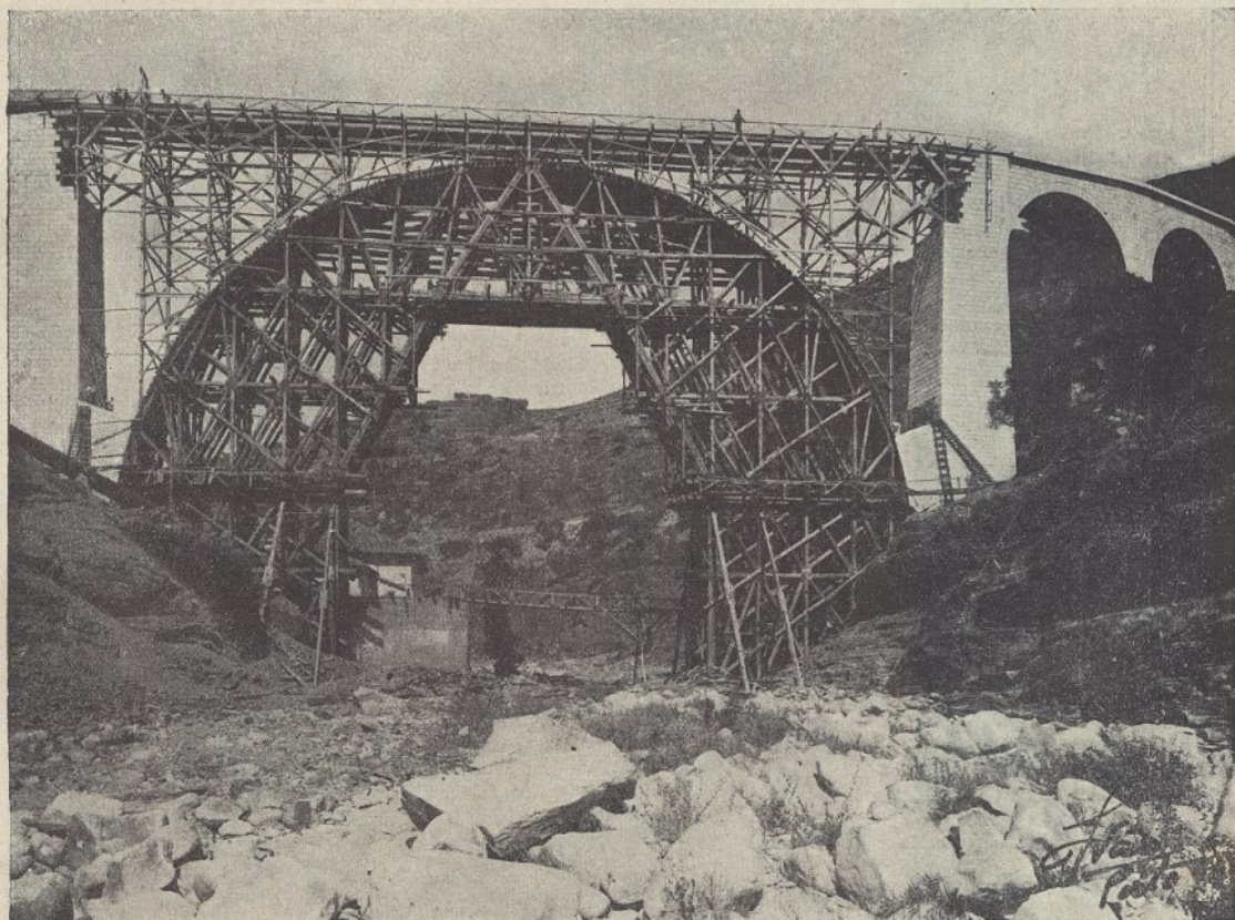
ARCO CENTRAL DA PONTE DO VAROSA
