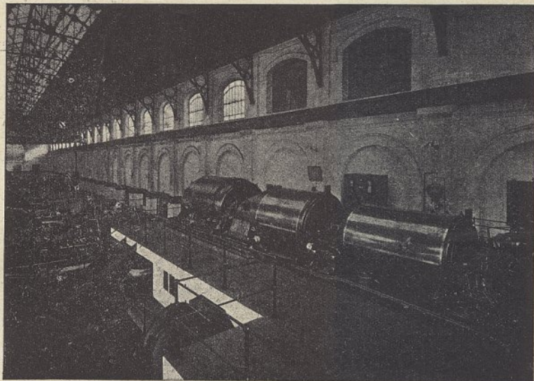
O turbo grupo a vapor de 3.000 kilowatts da Central de Massarelos da Companhia Carris de Ferro do Porto
