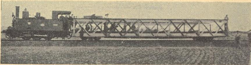
VALE DO VOUGA — Condução do taboteiro metálico, montado sobre 2 bogies, para o local da P. I.
