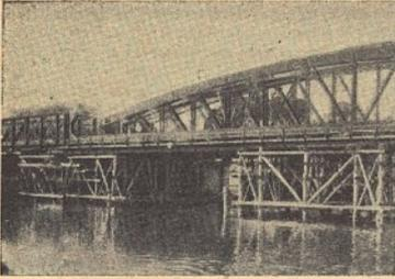
O tramo parabólico da nova ponte, vindo-se os pilares provisórios em madeira
