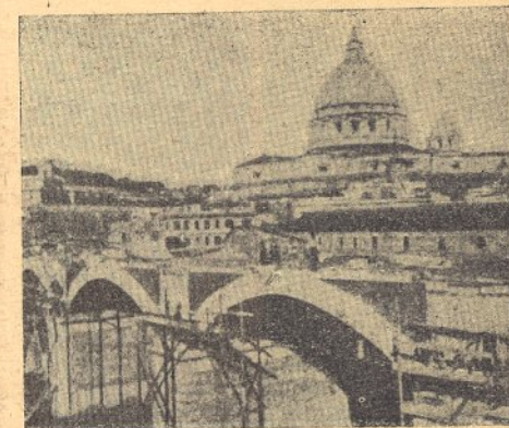
Vista do viaducto durante a construção
