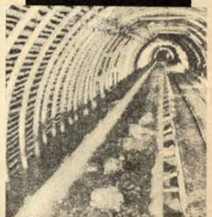
O transportador segue a galeria escorada com arcos de aço.
