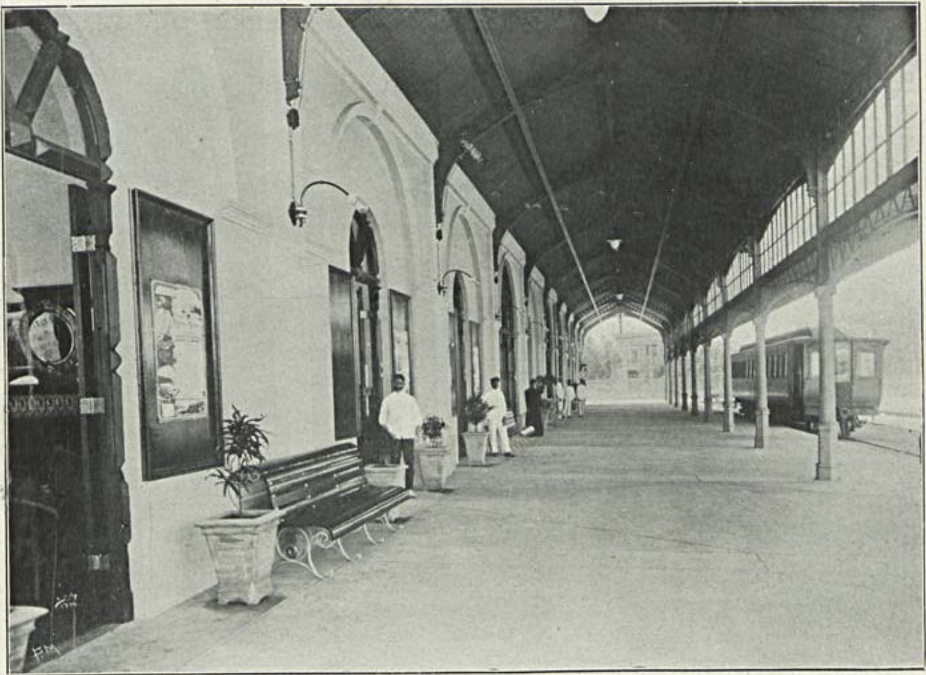
Plataforma do lado do mar
