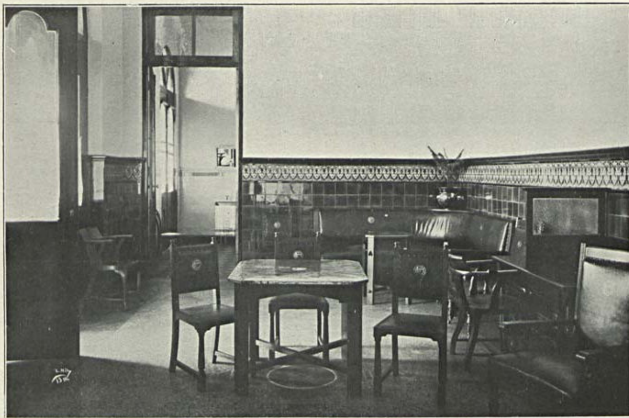
A nova estação do caminho de ferro de Lourenço Marques — Sala de espera para senhoras e toilette
