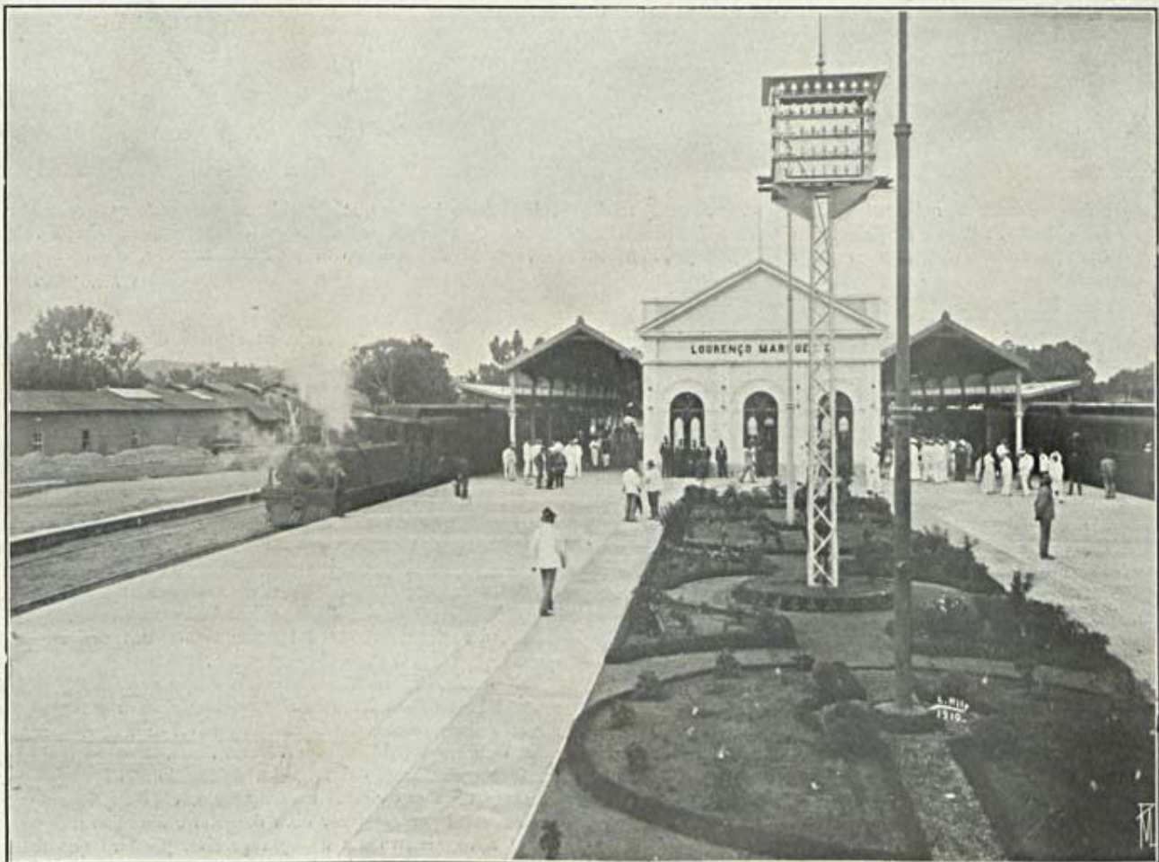
A estação vista do lado de Ressano Garcia
