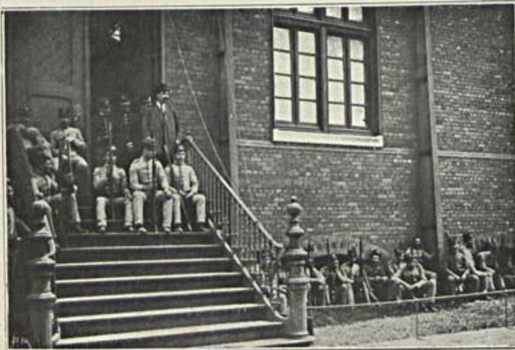
A fabrica geradora de electricidade guardada pela infantaria da guarda republicana
