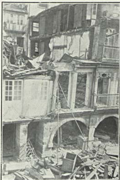
As casas do bairro de Miragaia destruidas pela explosão
