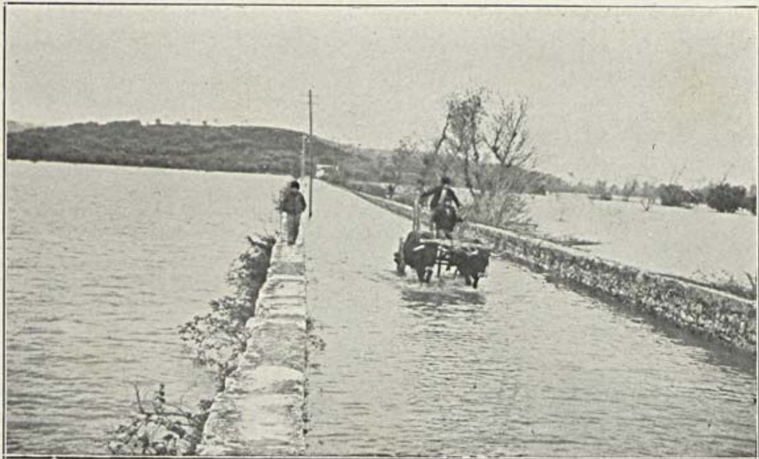
Os ultimos temporaes — A ponte da Ribeira d'Asseca completamente coberta d'agua
