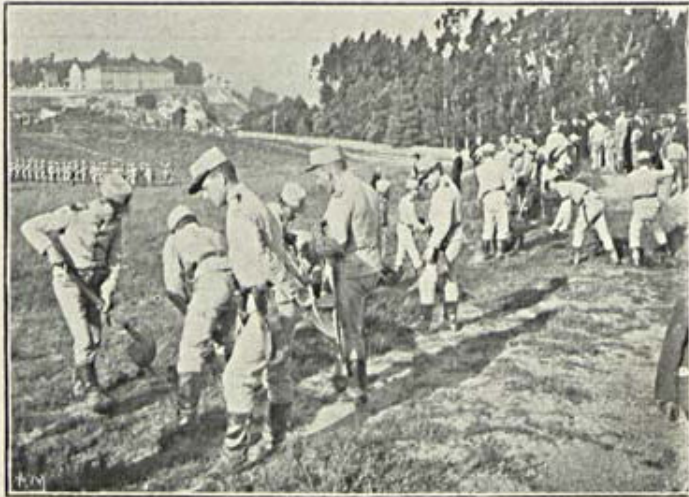
Construindo trincheiras para protecção das metralhadoras
