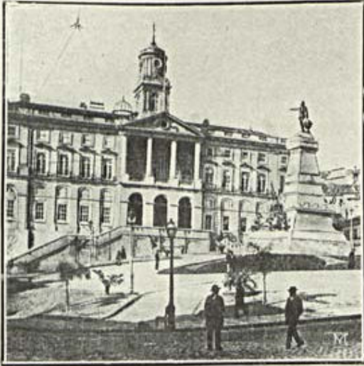
A fachada do edificio
