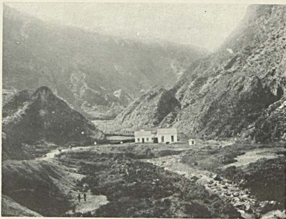
Valle das Lombadas — Edificio primitivo da laboração na nascente
