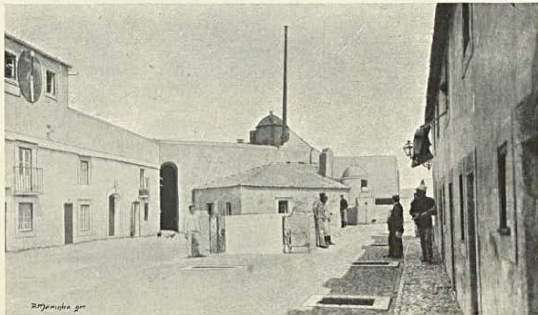
S. Julião da Barra. — Esplanada por onde se entra para os subterraneos
