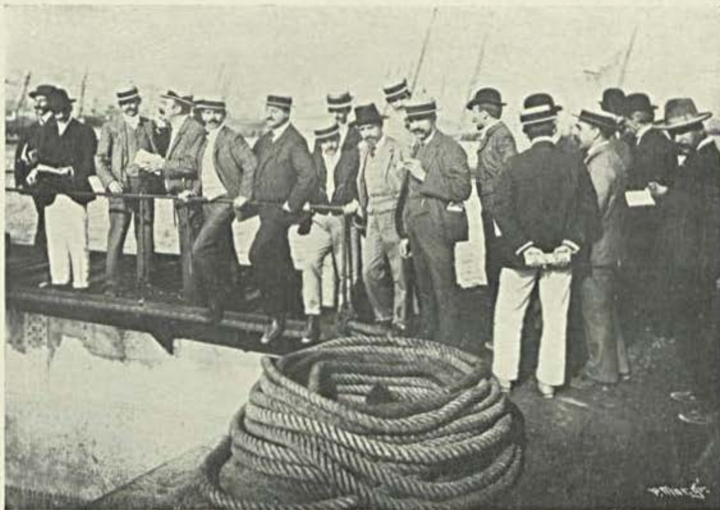
Na doca n.º 1 de reparações do Porto de Lisboa
